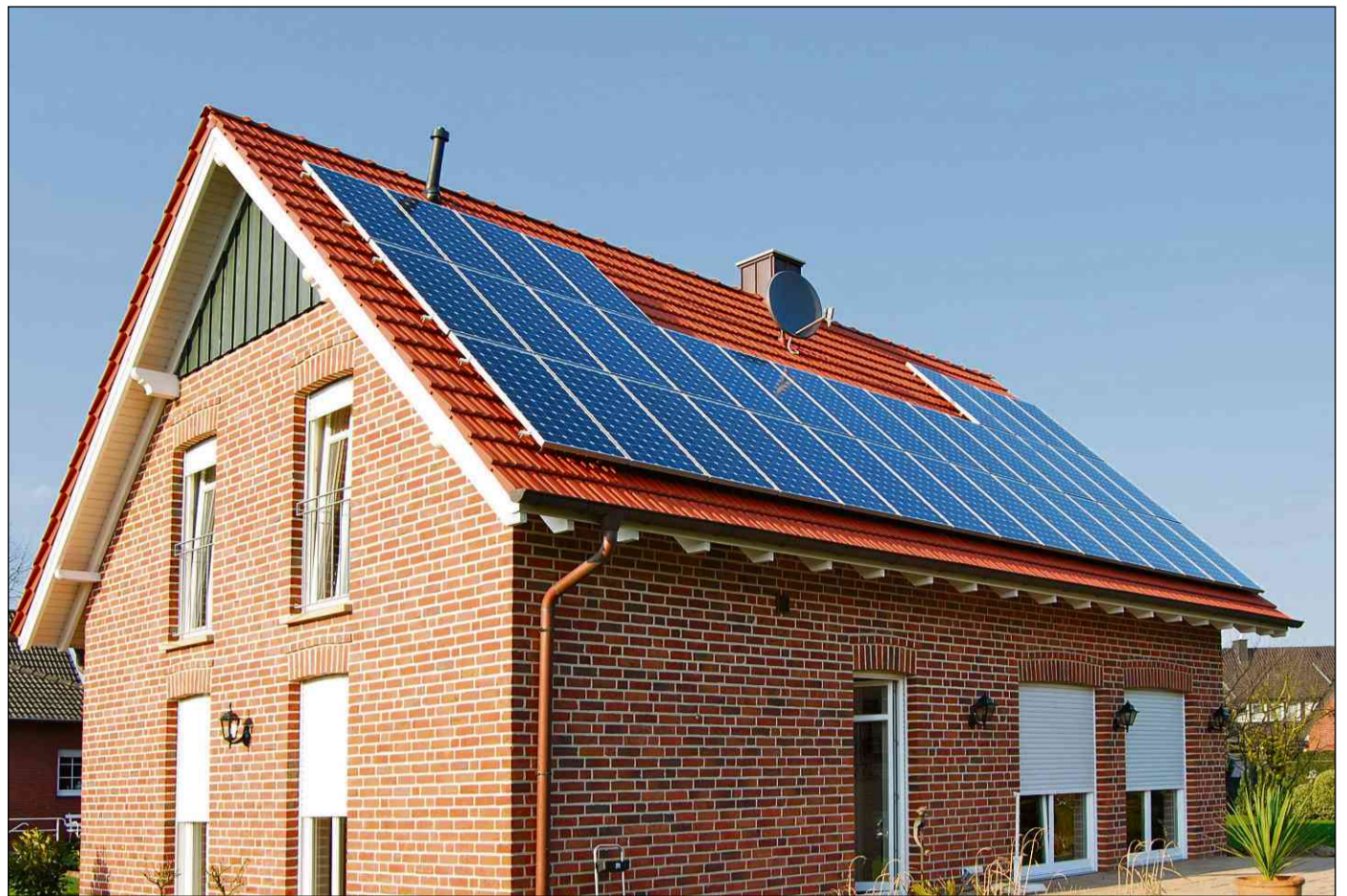
Die Kraft der Sonne nutzen mit einer Photovoltaikanlage auf dem Dach: Enerix macht's möglich
