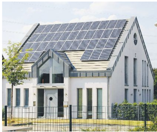
Hochwertige Komponenten, eine fachmännische Installation und Nachbetreuung garantieren langfristig hohe Solarerträge.
