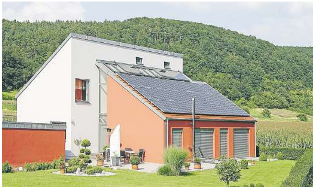
Eine Photovoltaikanlage wandelt Sonnenlicht in Solarstrom um.
