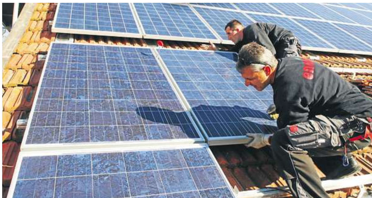
Die 18 Enerix-Franchise-Betriebe montieren deutschlandweit jährlich über 1000 Photovoltaik-Anlagen.
